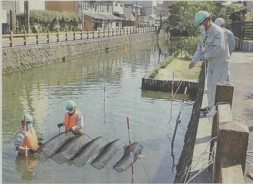
松江市と島根県の実証事業で北堀川で設置される防藻ネット—松江市母衣町(市提供)
