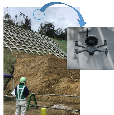
写真-1. UAVによる安全巡視
