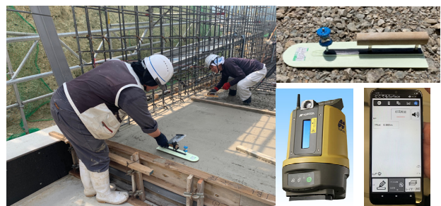
写真-2. コンクリート仕上げの簡易コテガイダンス
