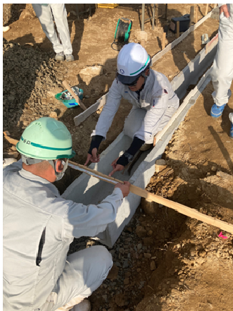
写真-6. MRグラスを用いた丁張レス施工の試行
